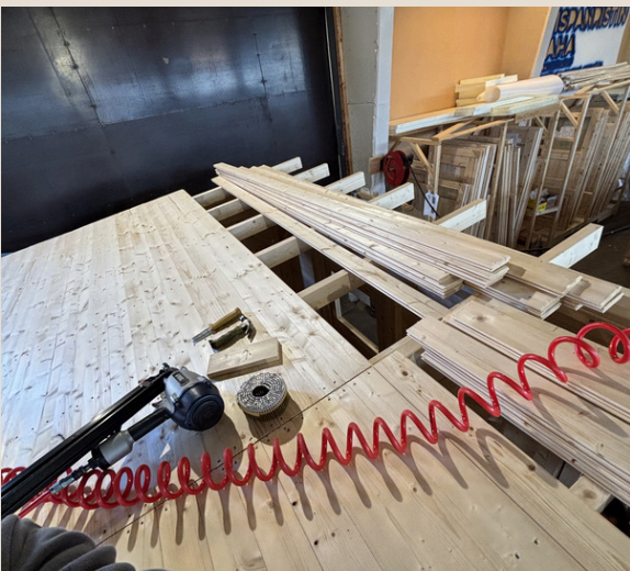
Bild 5: Nageln der Dachpaneelen auf die Dachbalken
