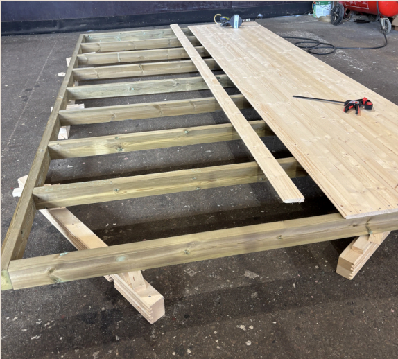
Bild 1: Bodenkonstruktion mit Bodenpaneelen
