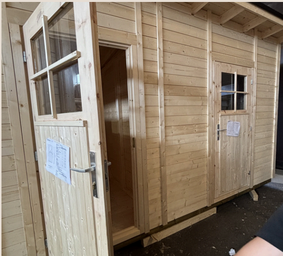
Bild 7: Einbau von Fenstern und Türen
