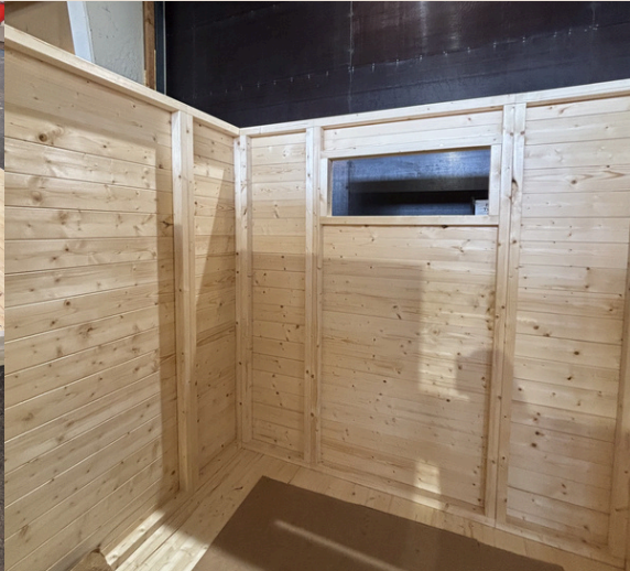
Bild 2: Aufstellen der Wände
