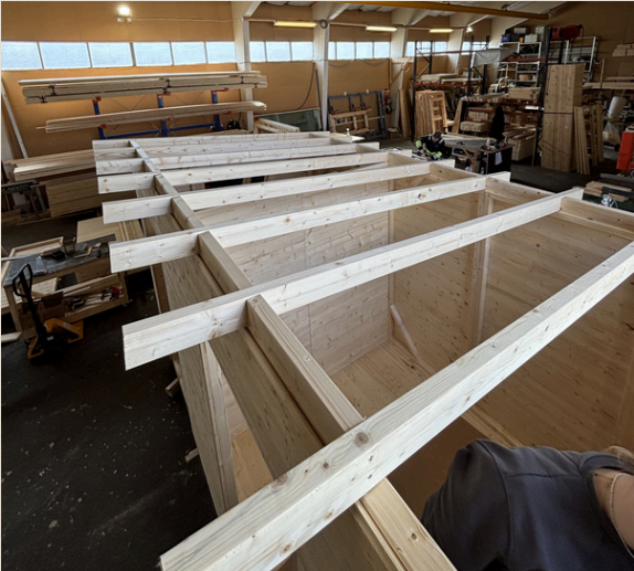
Bild 3: Setzen der Dachbalken
