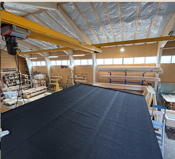
Bild 6: Verlegen und nageln der Dachpappe
